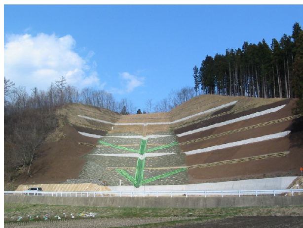
写真-1 完成写真
